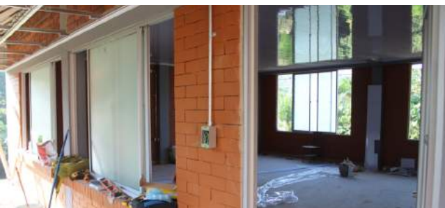
Registro fotográfico obra
