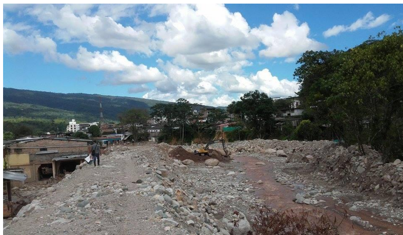
Figura 29. Actividad del dragado del rio en la parte del barrio el progreso
