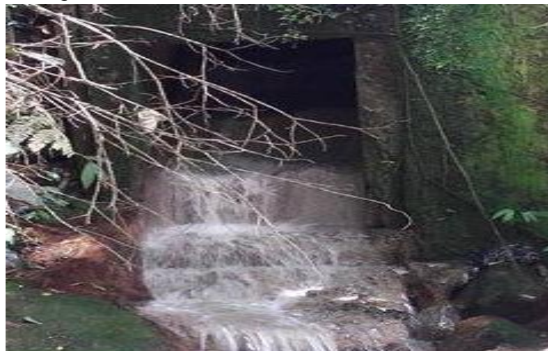
Figura 47 colector box culvert barrio Los Prados
