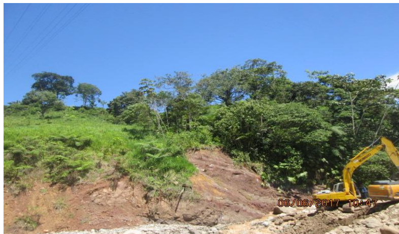
Figura 27. Dragado del río con Maquinaria
