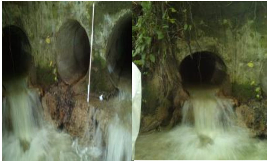
Figura 53. Punto de Vertimiento. Estación de servicios Los Bravo
