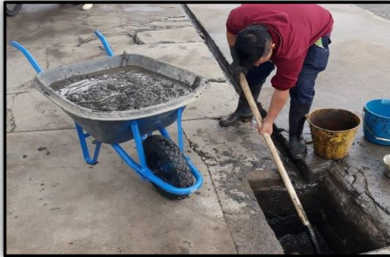
Figura 5. Extracción de los sedimentos de la trampa de grasa.
