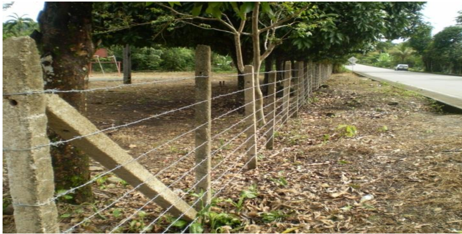
Figura 9 (mejoramiento cerca con postas de concreto) escuela vereda San José del Pepino
