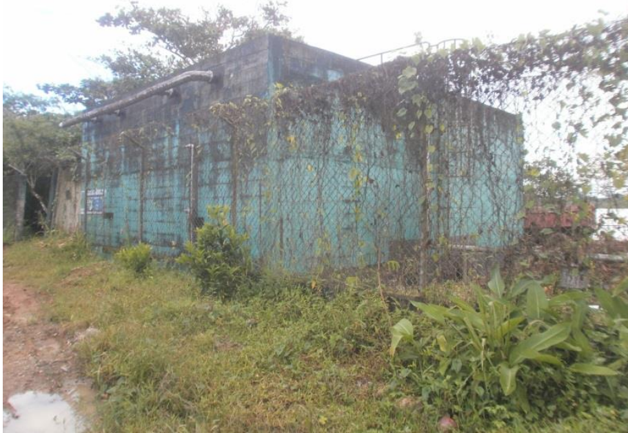
Figura 6. Foto planta de tratamiento de aguas residuales (inhabilitada).
