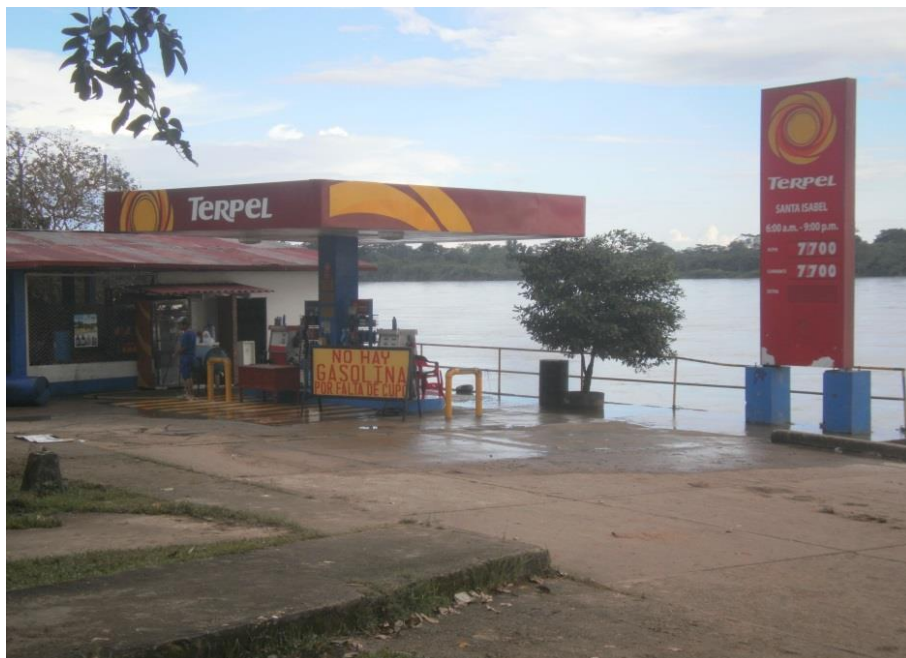
Figura 8. Foto estación de combustible Puerto Leguízamo.
