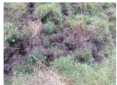
c. erosión por terracetas y hídrica.
