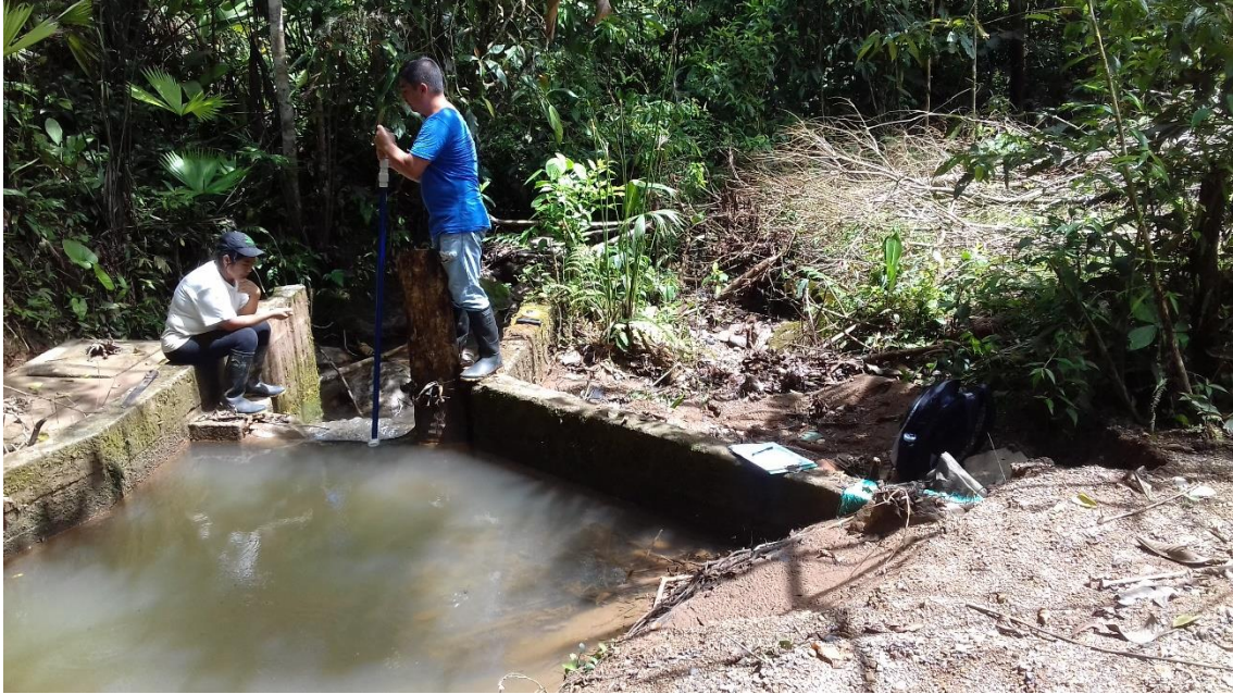
Figura 3 Bocatoma del acueducto de la vereda Ticuanayoy. Fuente: este trabajo
