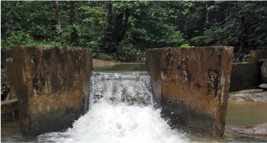
Figura 3. Bocatoma acueducto Alto Eslabón
