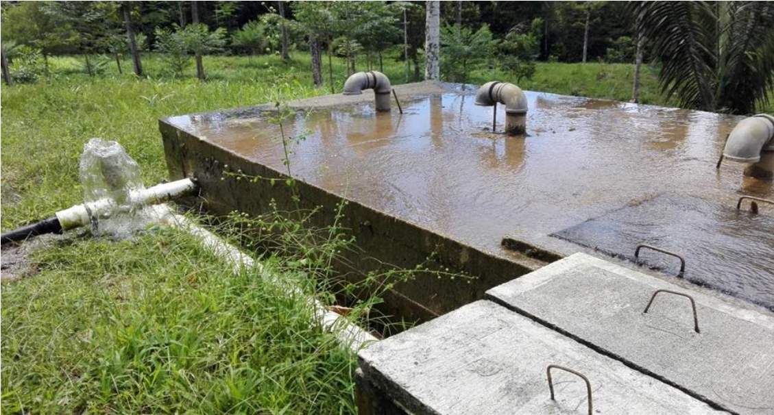
Figura 16 .Tanque de almacenamiento
