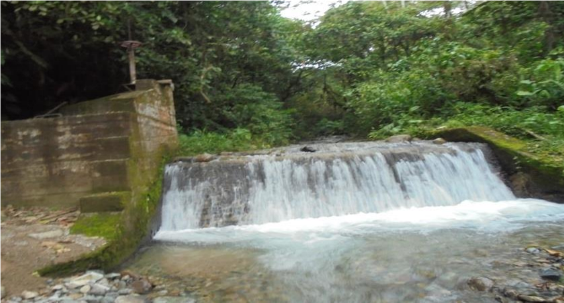
Figura 17. Bocatoma Acueducto abastecedor de vereda San Isidro Diviso.
