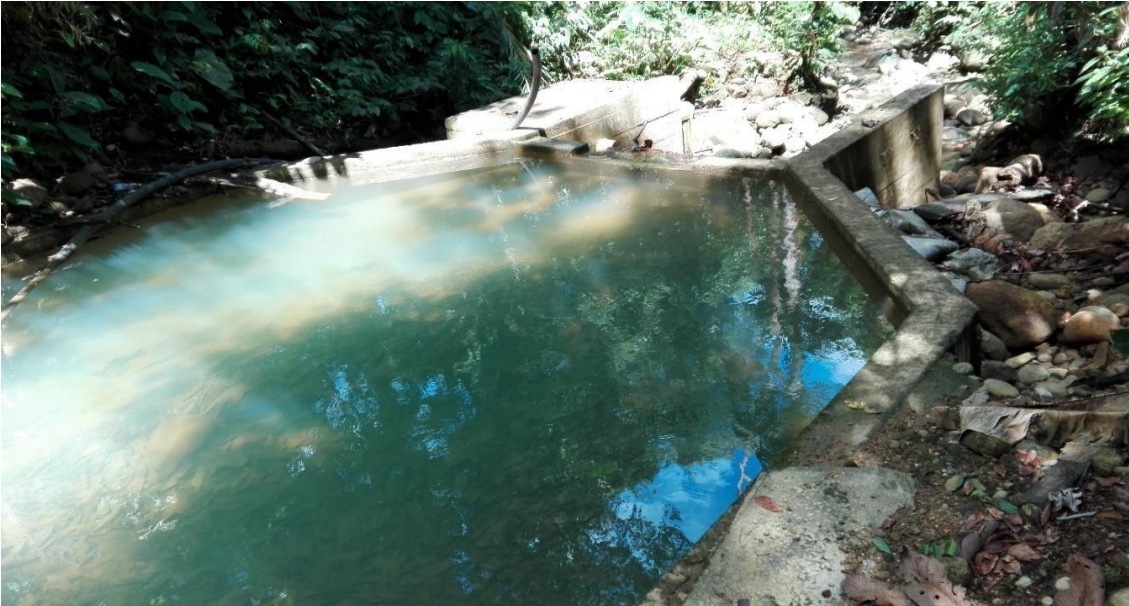
Figura 10. Bocatoma vereda Villa Gloria de Toroyaco.
